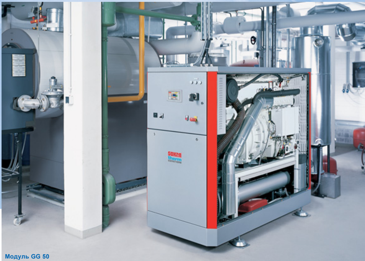
Подвод топливного газа, отвод горячей воды и дымовых газов
